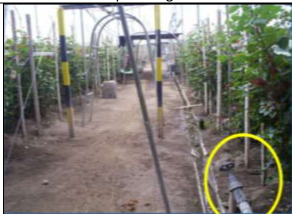
Fotografía 10: Válvula de control manual para riego
