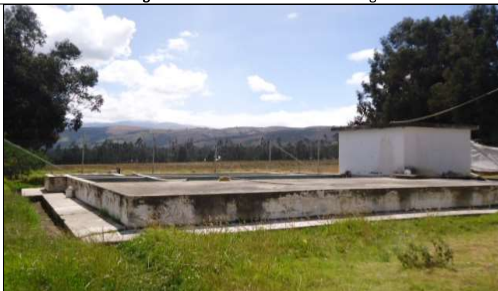
Fotografía 9: Planta Potabilizadora de agua
