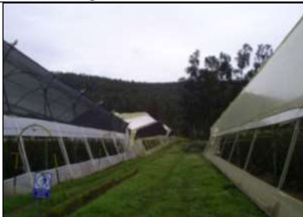
Fuente: Inspección en campo 2016
